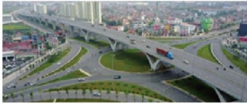
Hình 9.4. Cầu vượt thép tại nút giao Nguyễn Văn Cừ quận Long Biên, Hà Nội
